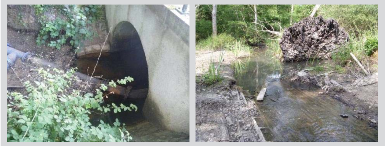
Aménagements dans le lit du ruisseau du Pont-Chevron (Clichés du 16 juillet 2013)
